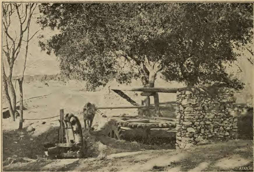
Cliché de l'auteur, janvier 1899.
